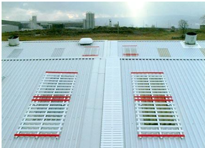
Figura ilustrează utilizarea unor platforme de protecție pentru distribuția uniformă a greutății pe zonele fragile ale acoperișului.
